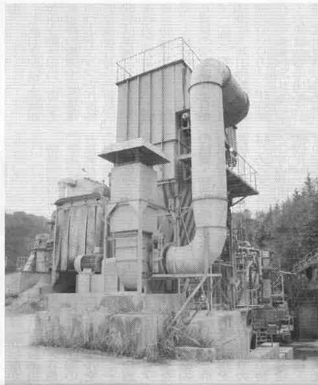
2基のエアセパレーターを設備する第5工場
