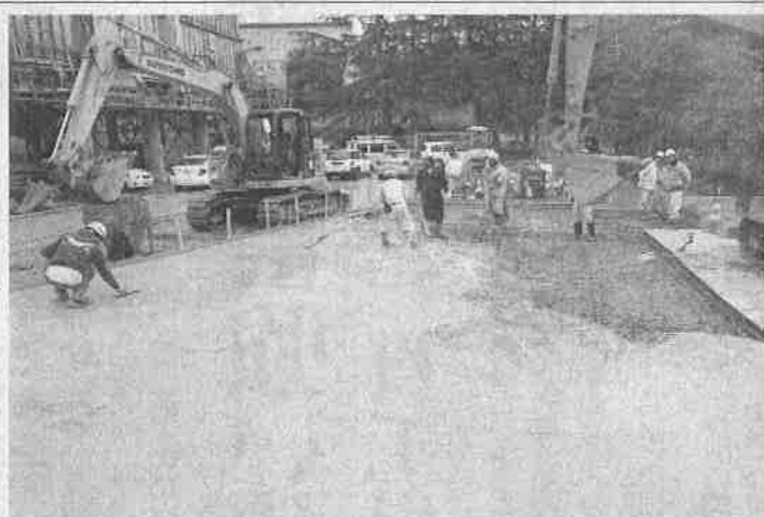
ほぼ半日で打込み・仕上げを終えた
