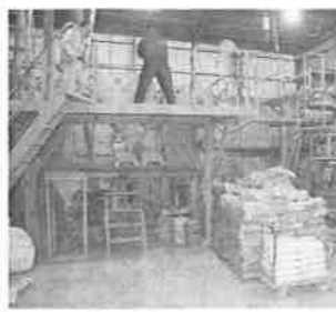
専用プラントでのモルタル(補修材)製造
