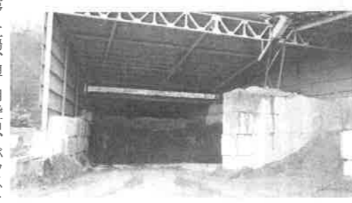
乾式砕砂のストックヤード。「立米ブロック」を仕切りに活用する
