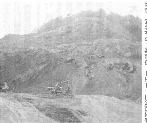
切羽の様子。北方面(写真奥)へ開発を進める
